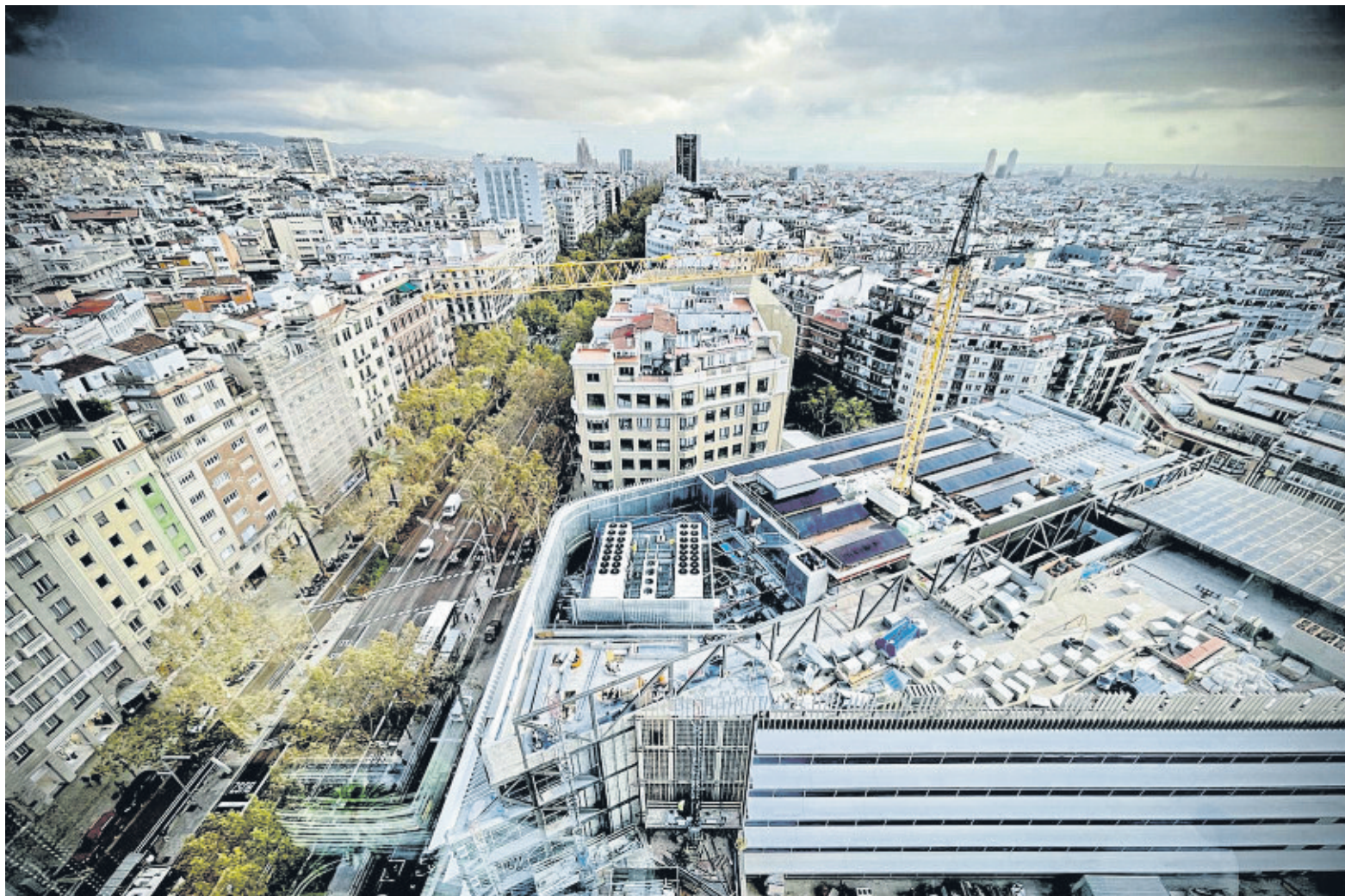
Obras en un edificio de la Diagonal
